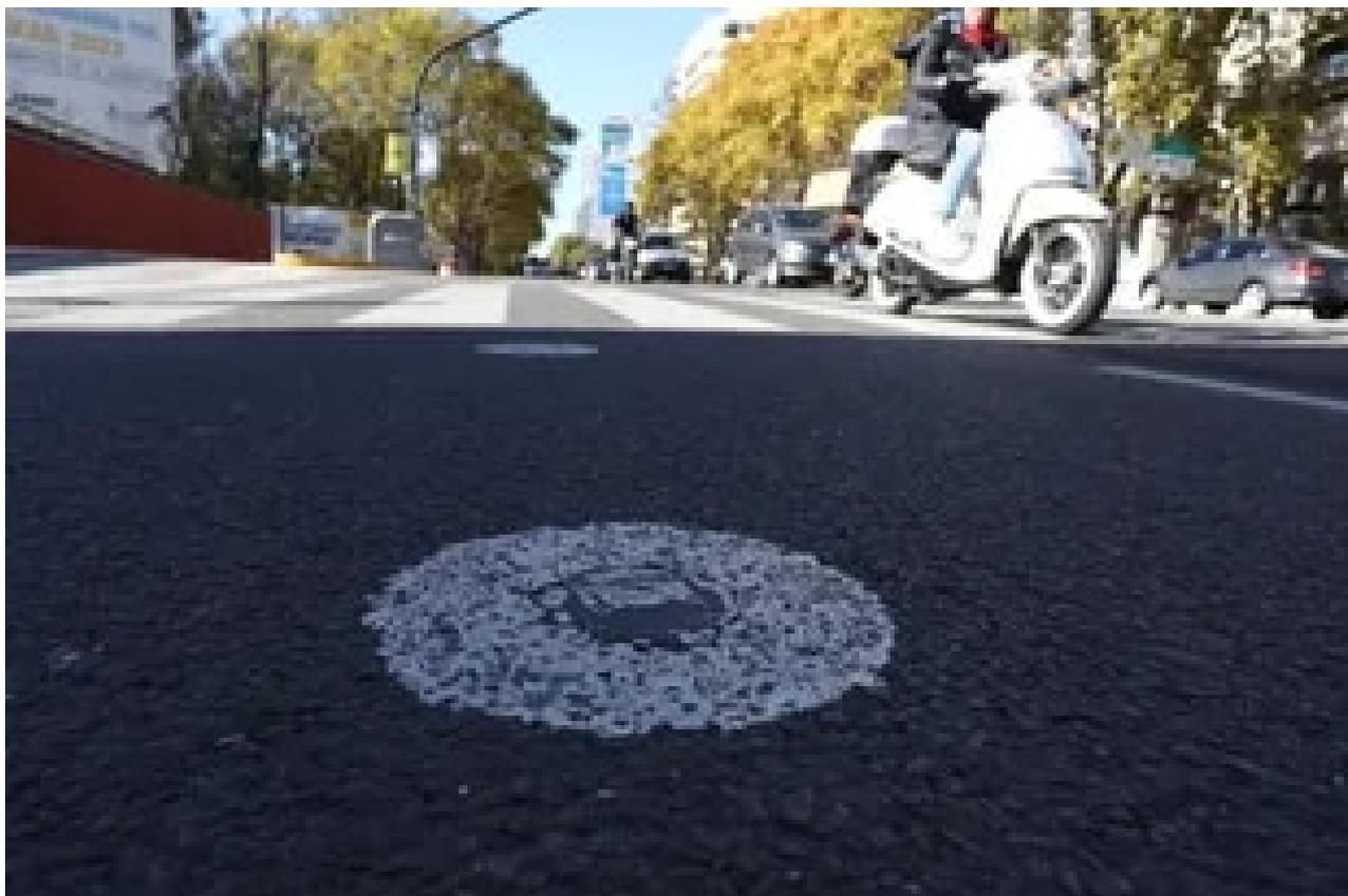
Colocados bajo el asfalto, los sensores, o magnetómetros, permiten controlar las variaciones del tránsito en tiempo realGerardo Viercovich
